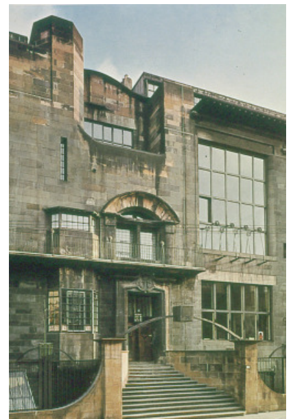
* Escuela de Bellas Artes . Glasgow. 1898-1909. MacIntosh . Formas austeras, muros macizos, grandes cristaleras en las aulas, valoración espacial de los ambientes y utilización de la asimetría en la fachada.
