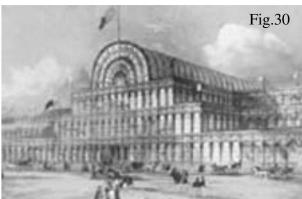
Fig.30. Crystal Palace, Londres. Lo construyó J. Paxton en tiempo record para la exposición de 1850. Tenía que cubrir 72.000 metros cuadrados. Mandó hacer 2.224 viguetas de hierro, 3.000 columnas y 300.000 elementos de cristal.
