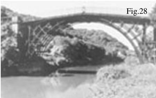
Fig.28. Puente de Coalbrookdale, Inglaterra, obra de Abraham Derby III, 1777-1779. Es el primer puente de hierro. Sus piezas están ajustadas con remaches.
